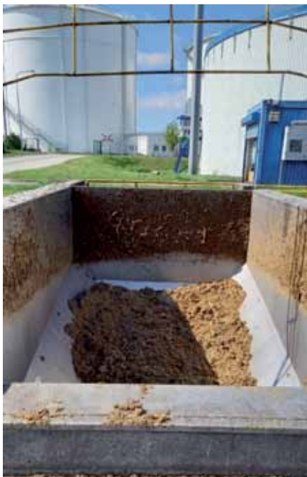
Rys. 4. Zbiornik na wysłodki przeznaczone do produkcji biogazu (Foto: Sz. Dziuba)
